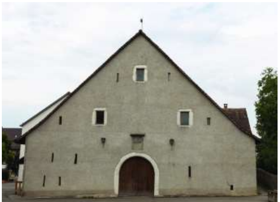
Die Trotte Löhningen wurde immer wieder saniert und ist für ihre zukünftigen Aufgaben gerüstet. Bild: smu
