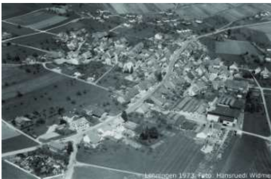
Am 27. Juli 2020 wurde mit dem Abbruch des letzten Teils der ehemaligen Zaunfabrik begonnen. Das Luftbild aus dem Jahr 1973 zeigt das grosse damalige Fabrikgelände. Links im Bild der „Schandfleck“ Autofriedhof.
