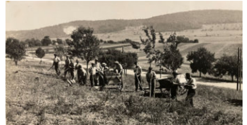
Viel Handarbeit war angesagt beim Anlegen der neuen Güterstrassen.
