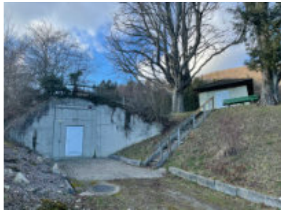
Das Reservoir ist äusserst wichtig für die Wasserversorgung im Dorf. Bild: emm
