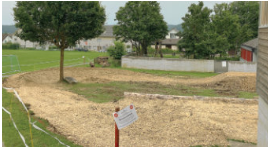
Zwischen der Turnhalle und dem Kindergarten entsteht ein Bike-Technikpark. Bild: R. Meili
