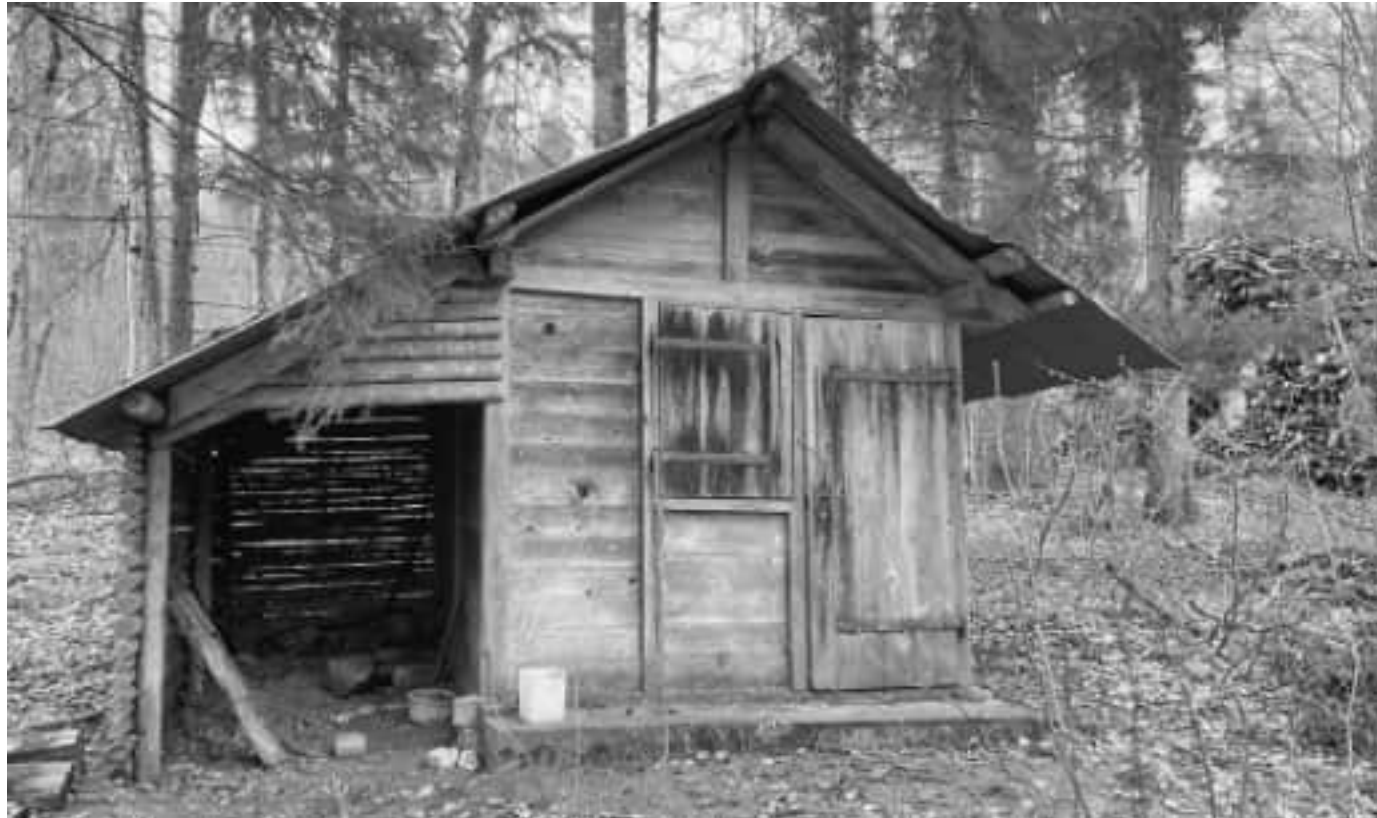
Die Forsthütte auf der Ebni wurde altershalber abgerissen.
