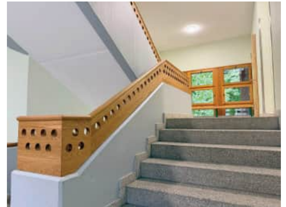
Der Aufgang zum Kleeblattsaal und weiter in die oberen Räumlichkeiten erhielt ein neues Geländer. Bild: zvg
