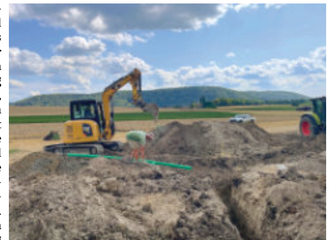
Rohre werden mit richtigem Gefälle in die Gräben verlegt.
